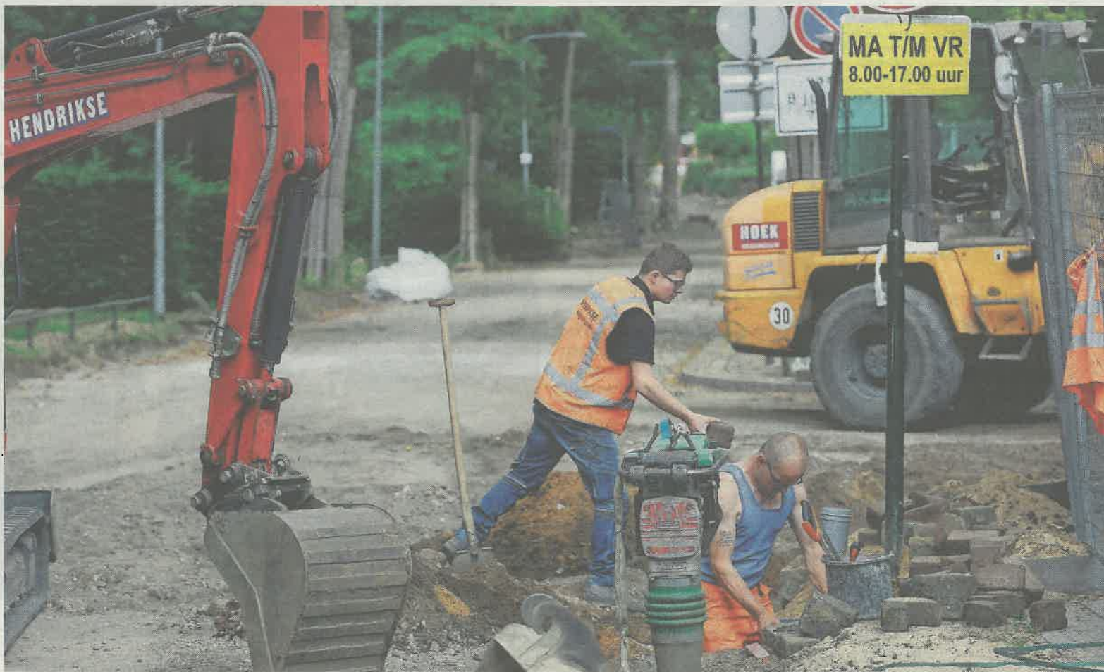
Voorzichtig graven om geen oude leidingen te raken.
